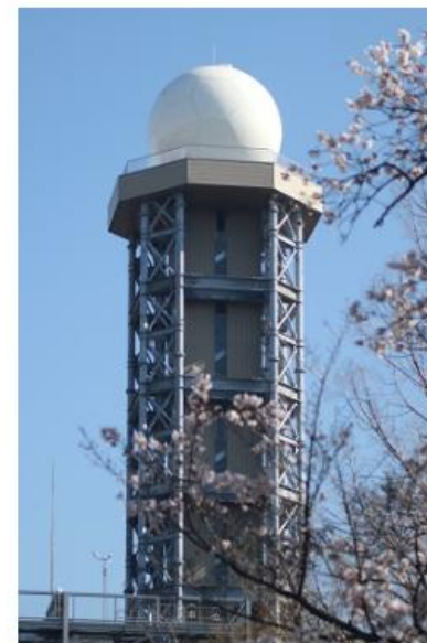
東京レーダー（千葉県柏市）
